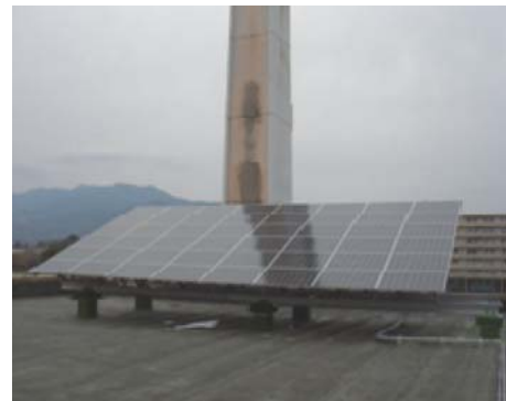
太陽光パネル設置
